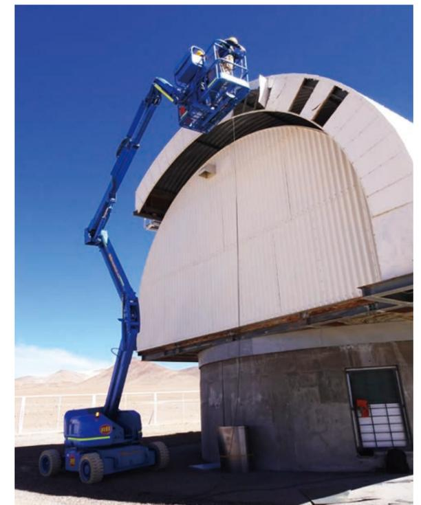
図3 穴が空いたドームの外壁の補修工事。壊れたパネルをとり外している。
